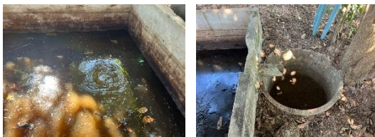
ภาพประกอบที่ 8 บ่อล้นและบ่อรับกากจากบ่อล้น
